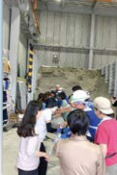
▲土のうづくりと 汚泥除去体験
